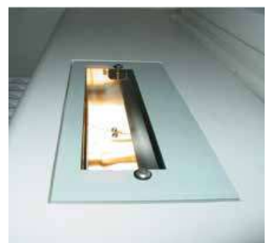
Laibungslicht in Fensterbank
