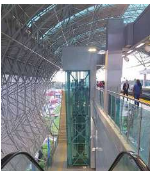
Aufzug- und Säulenverkleidung
