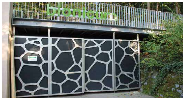
Torverkleidung am Bionikum
