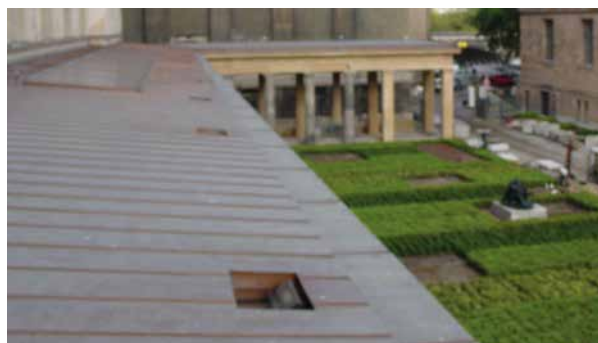
Fassadenstrahler im Dach
