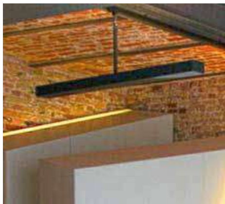
Indirekt-Pendelleuchte
