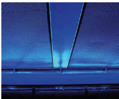
Lichtkanal unterhalb der Decke
