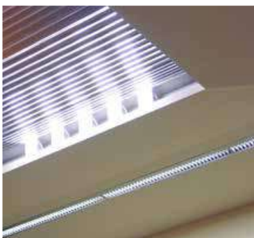
Wallwasher-Lichtband
