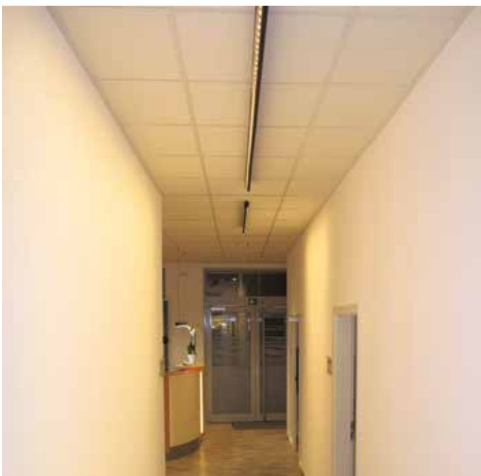
Abb.: Der Flur wurde mit zwei Wallwasher »LYSO« mit tunable white-Funktion und asymmetrischer Abstrahlcharakteristik ausgestattet. Speziell geformte RDB-Reflektoren ermöglichen die vollflächige und blendfreie Ausleuchtung der Wandflächen.
