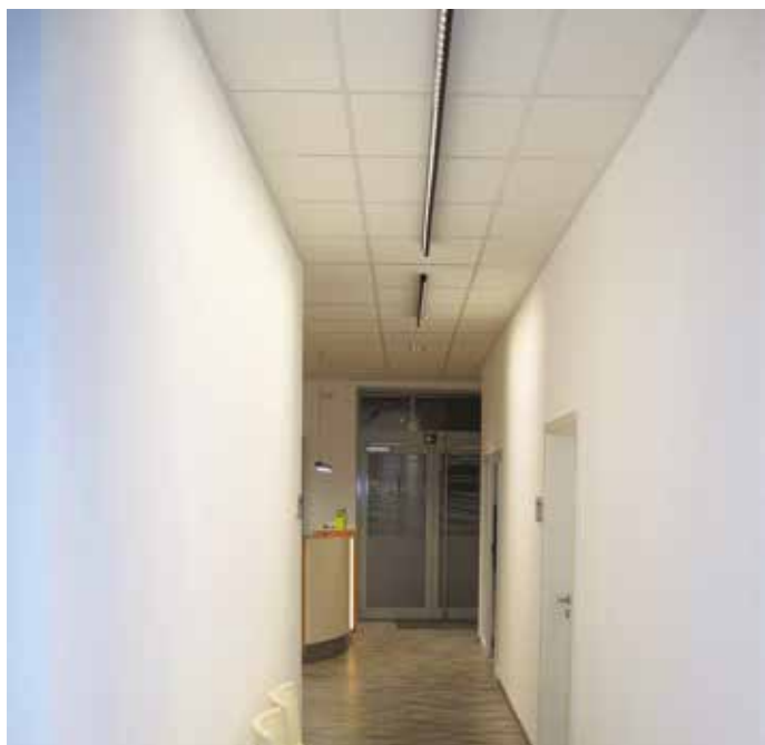
Abb.: Der Flur wurde mit zwei Wallwasher »LYSO« mit tunable white-Funktion und asymmetrischer Abstrahlcharakteristik ausgestattet. Speziell geformte RDB-Reflektoren ermöglichen die vollflächige und blendfreie Ausleuchtung der Wandflächen.
