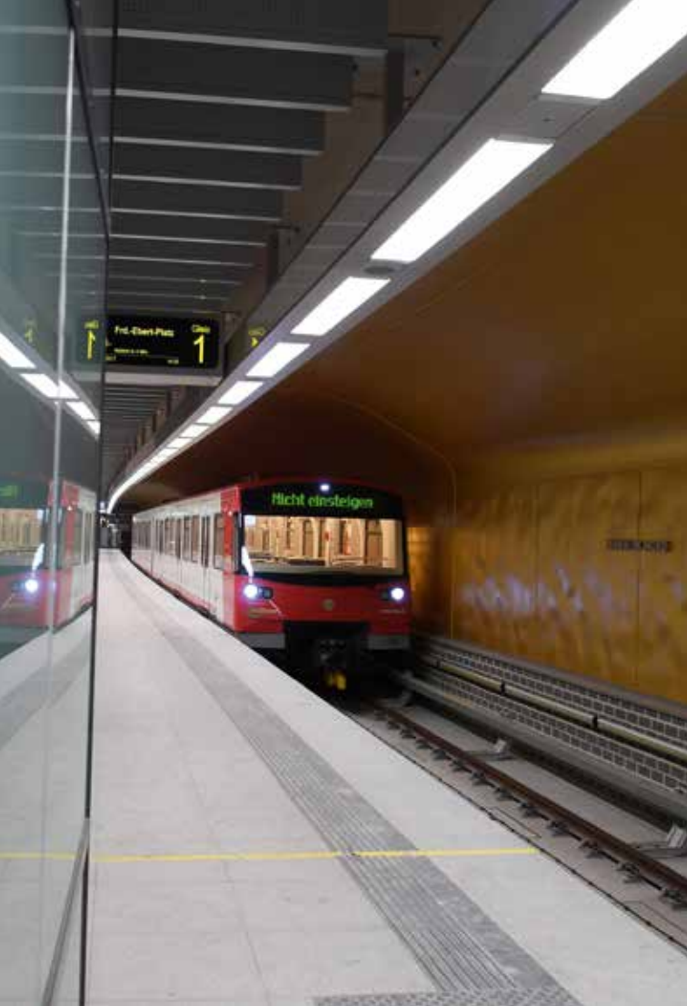
Abb.: Neben der Bahnsteigbeleuchtung sind in den Lichtbändern seitlich hinterleuchtete Schriftfelder untergebracht. Foto: VAG-Peter-Roggenthin
