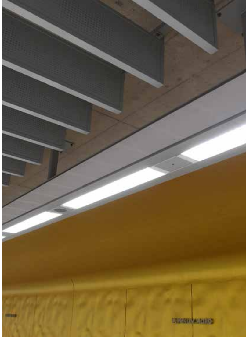
Abb.: Über die 500 mm langen Stahlpendel werden die Leuchten abgehängt. Foto: VAG-Peter-Roggenthin
