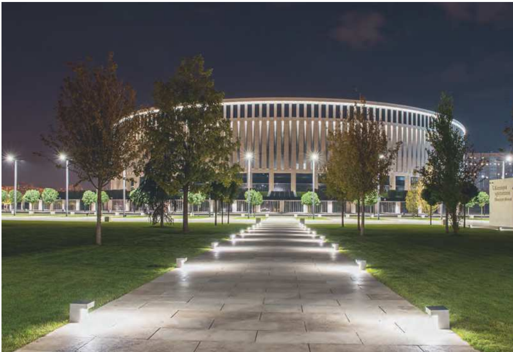
Die LMT Leuchten + Metall Technik GmbH aus Hilpoltstein lieferte zahlreiche Sonderleuchten nach Krasnodar, die speziell für das dortige Stadionprojekt entwickelt und produziert wurden. Foto: gmp/Adel Bikulov
